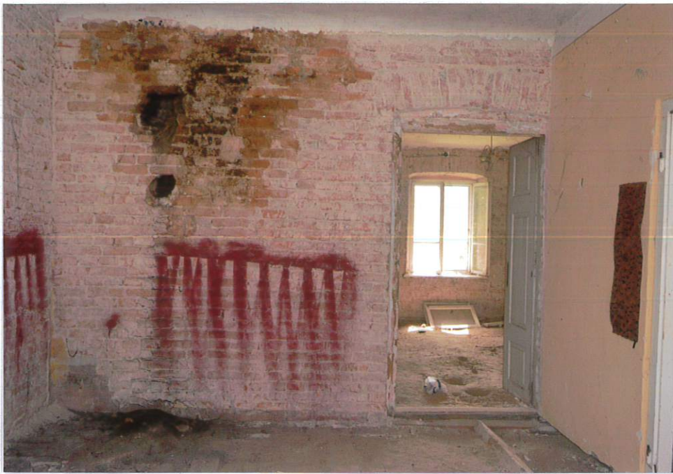
Fot. 14. Pom. nr 12, widok na tylny trakt (pom. 10), 2022.
