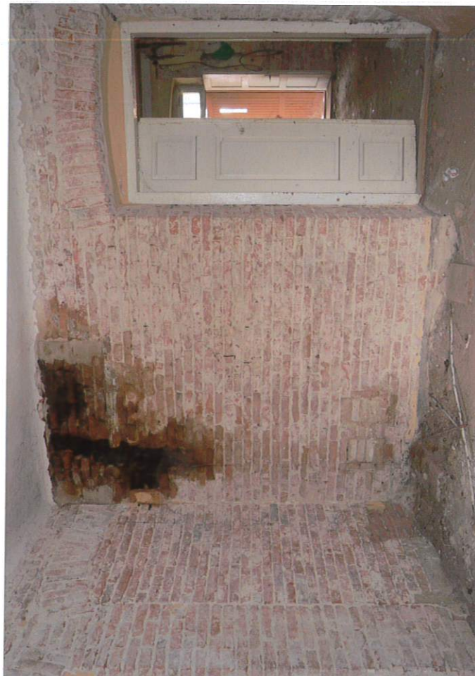
Fot. 12. Pom. nr 9, widok na wejście do sieni (pom. 1), 2022.
