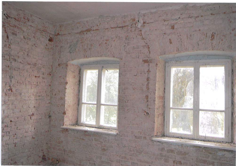
Fot. 9. Pom. nr 6, widok na ścianę południową, 2022.
