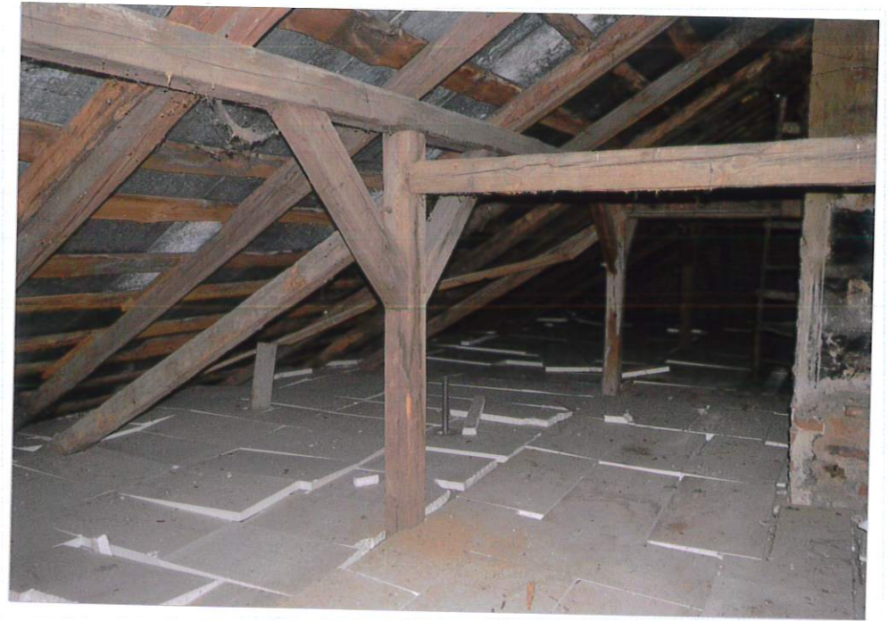
Fot. 15. Więźba dachowa, 2022.
